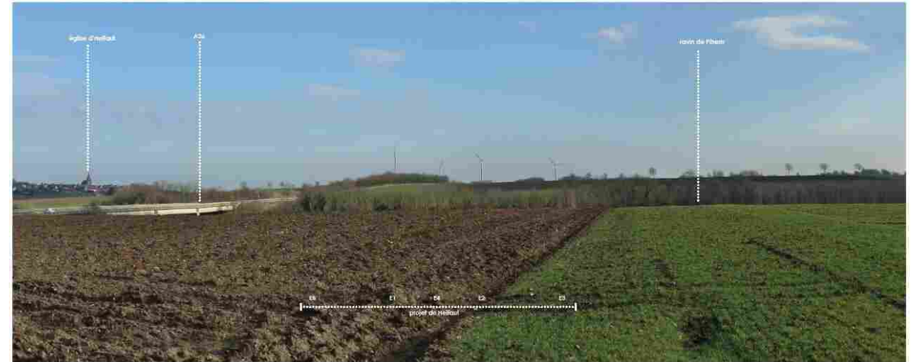
Figure 21 : PM n°9 – A26 / RD 928 à l'Ouest d'Helfaut (source : Epure, 2017)
